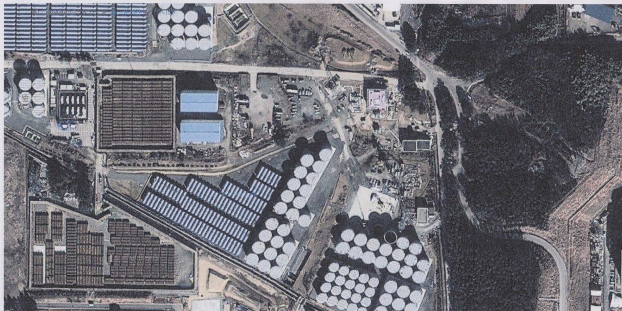
(図-4) 福島第一原子力発電所汚染水タンク
