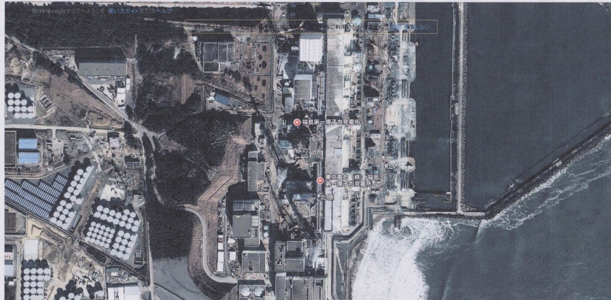
(図-3) 福島第一原子力発電所全体写真 1号機の原子建屋覆いが良く見える
