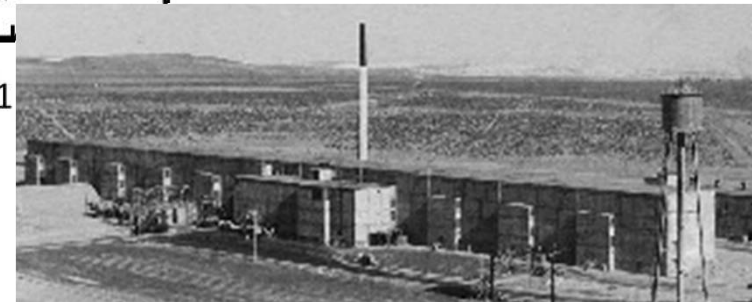
ハンフォードの再処理工場B-plant “Queen Mary of the sagebrush” ・1944年12月運開 ・リン酸ビスマス法(沈殿法)
