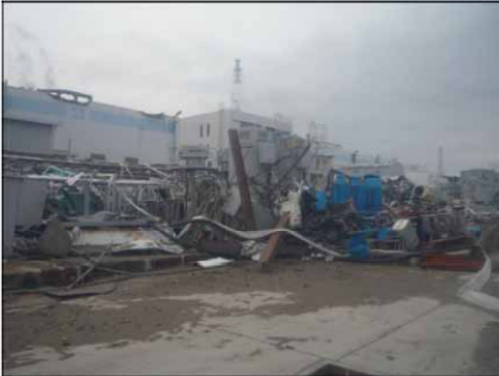
3号機海水ポンプエリア近傍を撮影
