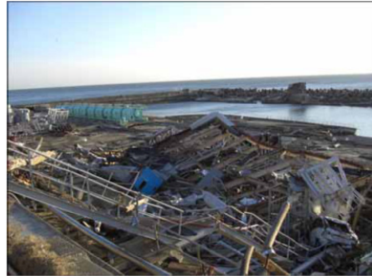
5・6号機取水設備周辺を撮影
