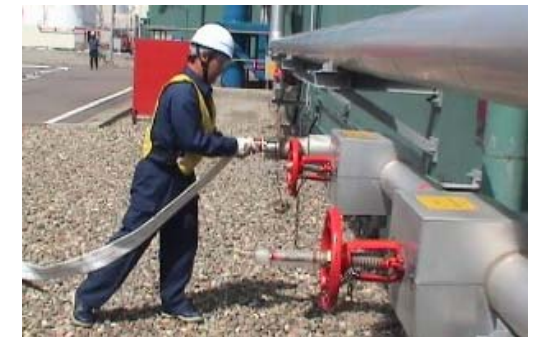
消防車による注水訓練
