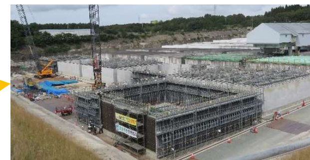
1号7,8群の工事の様子 (2022年9月現在)
