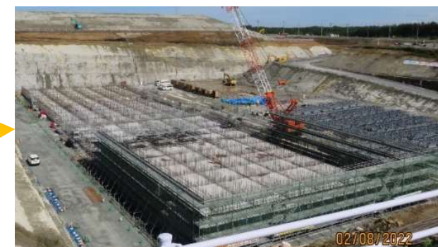
3号の工事の様子 (2022年8月現在)
