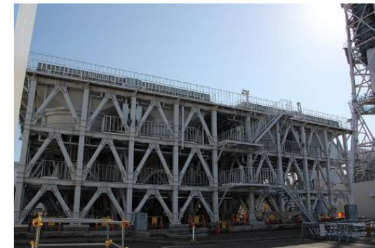
防護ネットの設置状況
