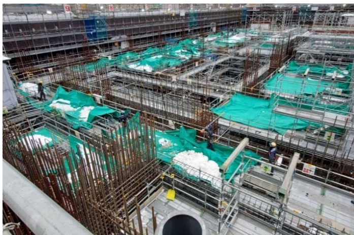
建屋工事の状況
