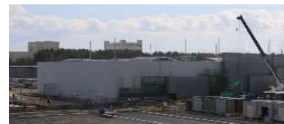
第1 保管庫・貯水槽
