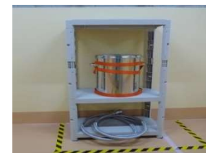
可搬型中性子吸収材供給器
