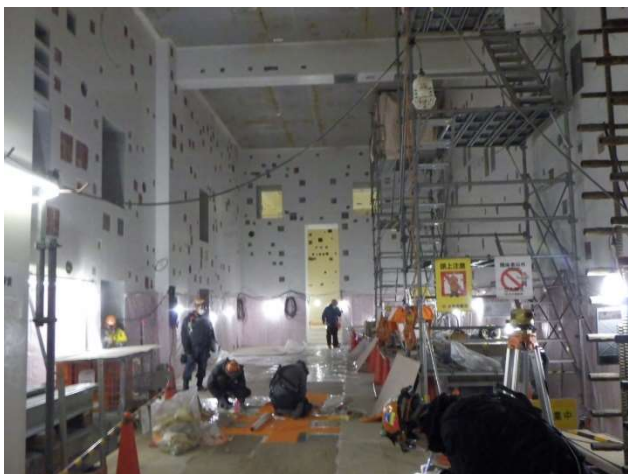
地下3階工事の様子
