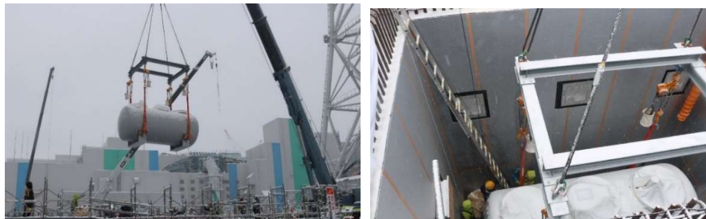
薬品貯槽を大型クレーンで地下8mにある設置場所へ据付
