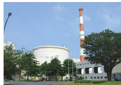
高速実験炉「常陽」
