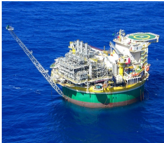
円筒形状の浮体構造物
