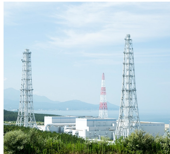
原子力発電設備
