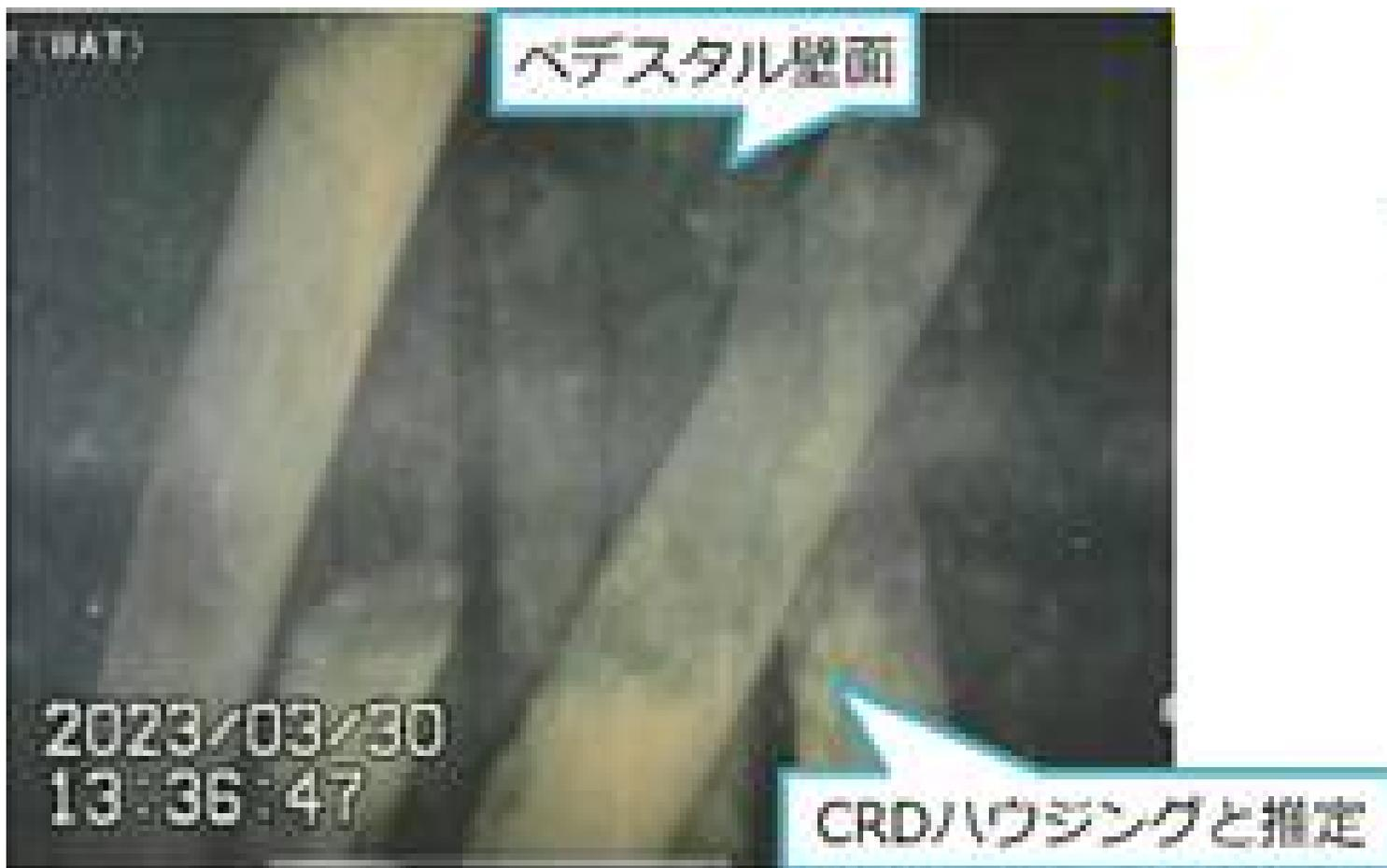
写真3 3本一組で落下したとみられる制御棒駆動機構ハウジング写真
