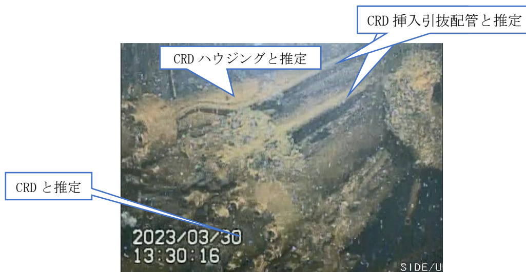
写真3 3本一組で落下したとみられる制御棒駆動機構ハウジング写真
