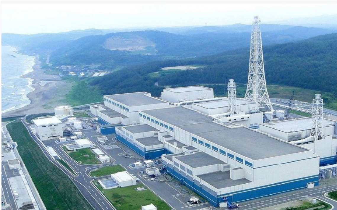
柏崎刈羽原子力発電所
