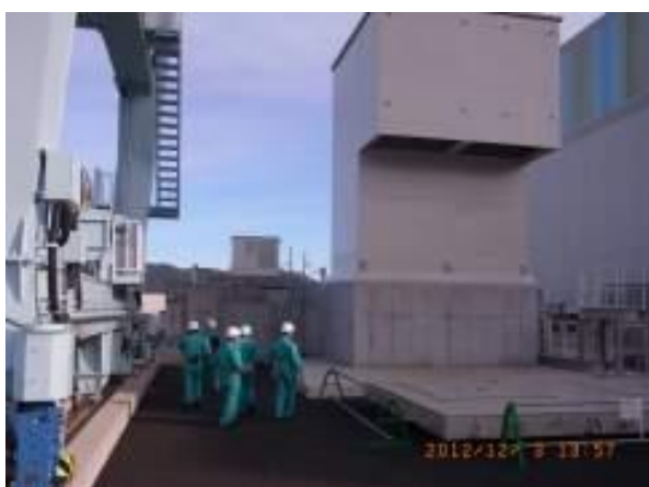
右の暗渠に海水ポンプ室、上部に換気口
