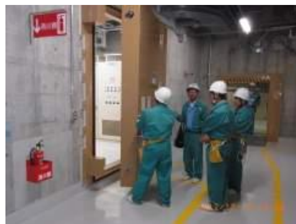
建物内外に金庫並みの扉が約 60 箇所、軽く開閉可能
